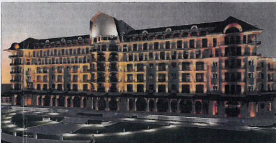
Environ 50 millions d'euros vont être consacrés aux travaux de rénovation. Preuve de la désuétude du bâtiment, les seuls aspects techniques représentent 30 % du budget. En comparaison, l'enveloppe technique ne pesait que 10 % sur la restauration de l'hôtel Ermitage menée en 2010. Photo Nazzerro MUNDA
