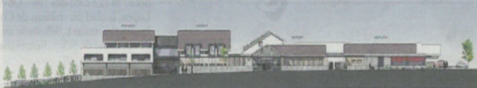
Le futur groupe scolaire après sa restructuration depuis l'avenue de Lonnaz, et vue du restaurant et l'école sur sa façade sud-ouest.
